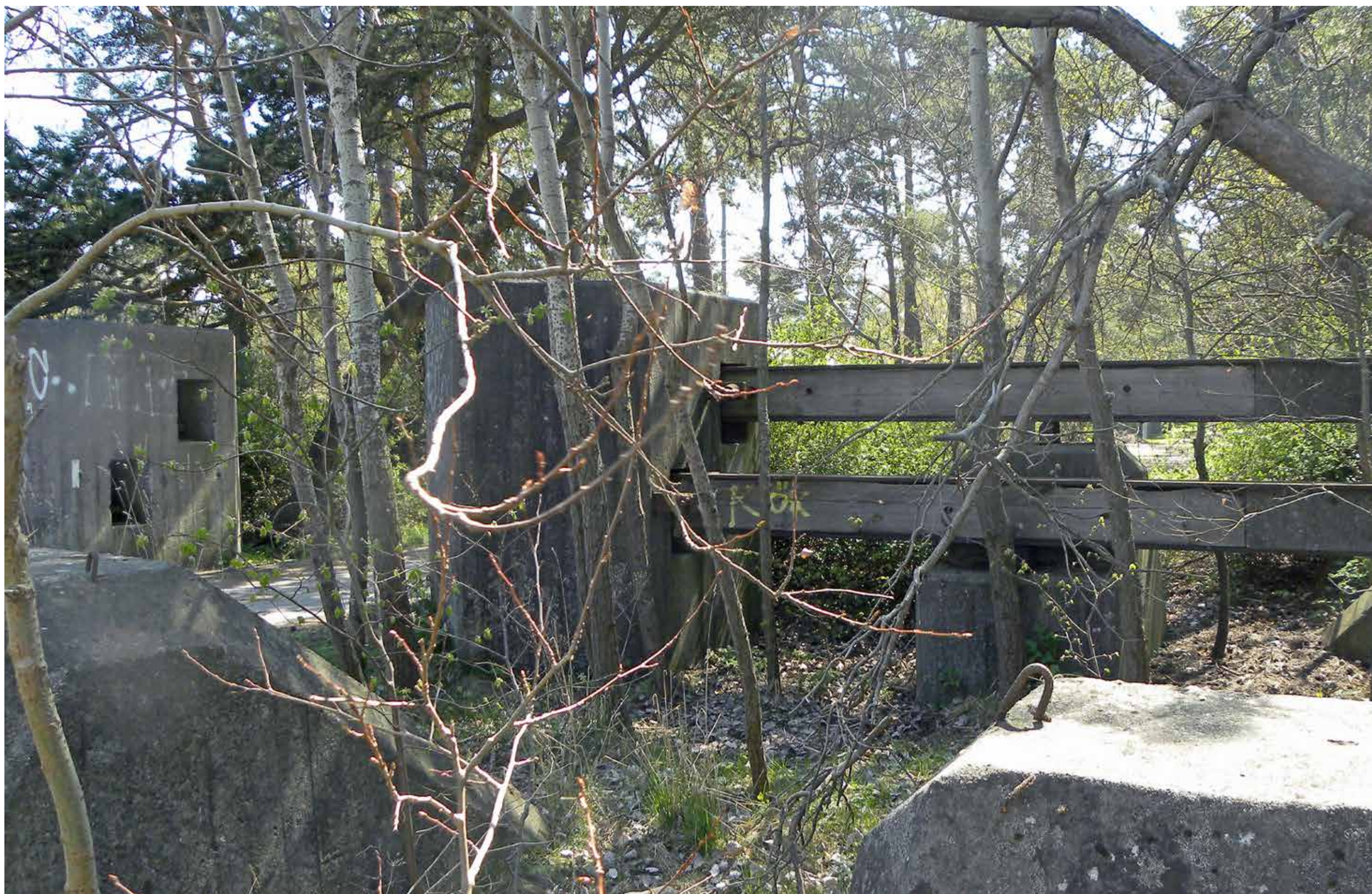
Balkspärr vid ingången till försvarsområdet vid kanalen.
