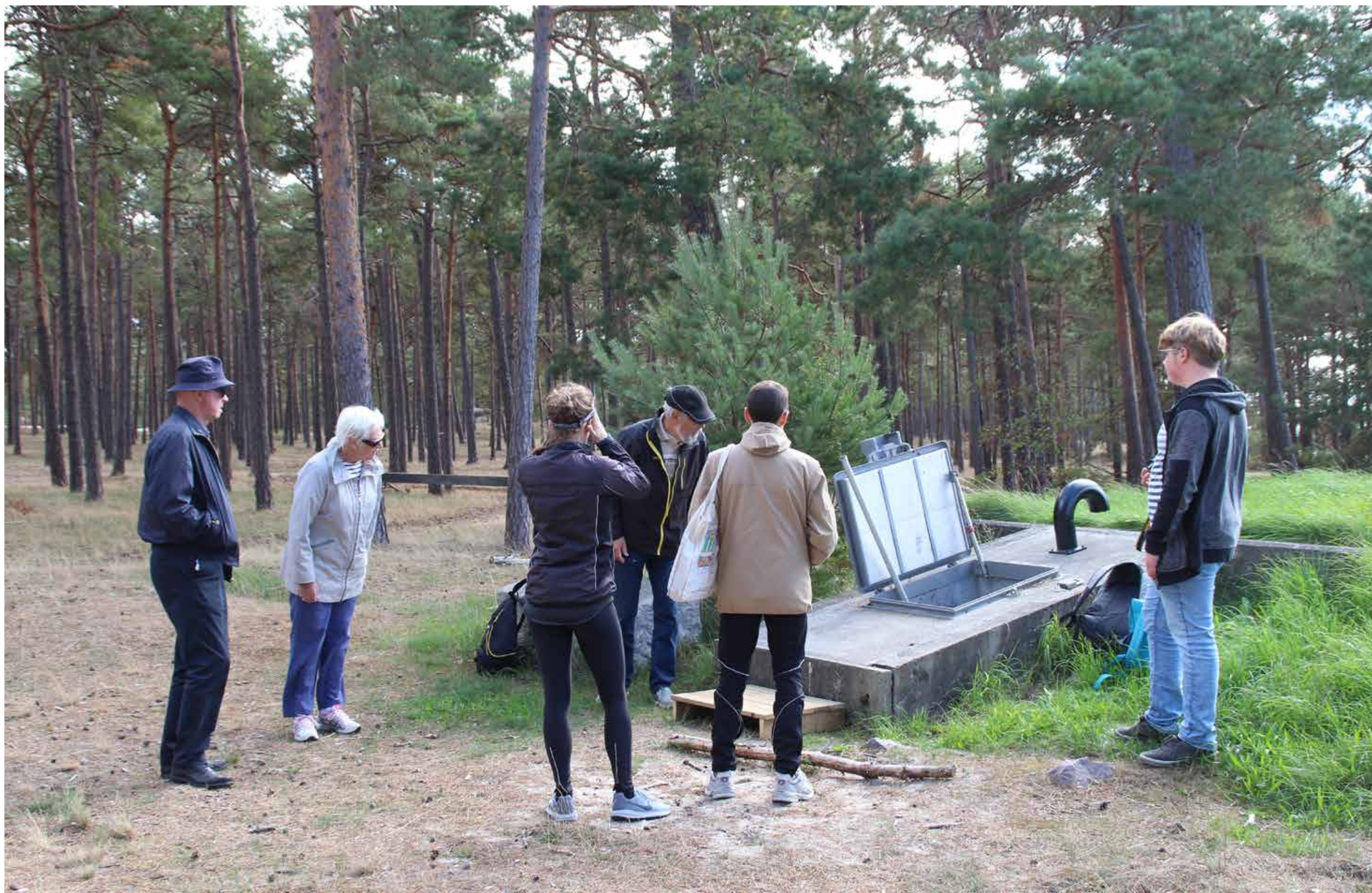
Nedgång till skyddsrum SK 24. Skyddsrum för 24 liggande soldater, byggt 1942.
