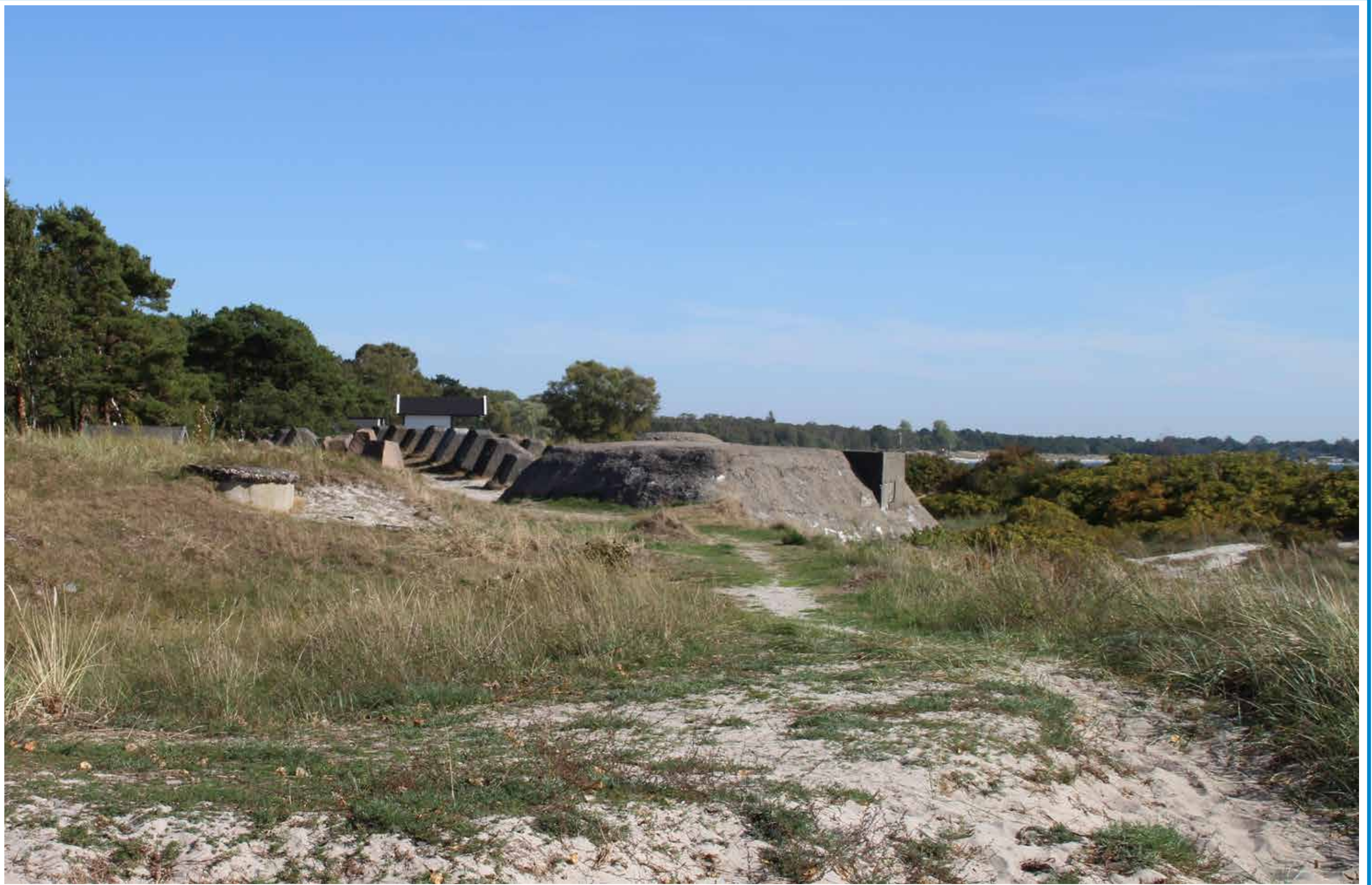
Värn, ursprungligen med pansarvärnskanon, byggt 1939. Byttes 1963 ut mot stridsvagnstorn.
