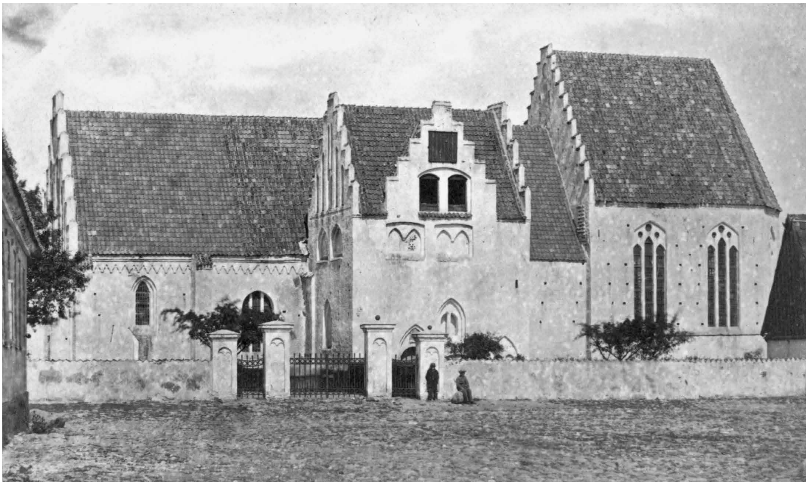
Skanörs kyrka omkring 1878. Skolan skimtar till vänster och till höger ser vi en gavel av Klockaregården. Denna låg inne på kyrkogården och revs omkring 1890. Lägg märke till alla hålen i kyrkomurarna. De användes till att fästa balkar för byggnadsställningar då kyrkan skulle kalkas eller taket tätas.
