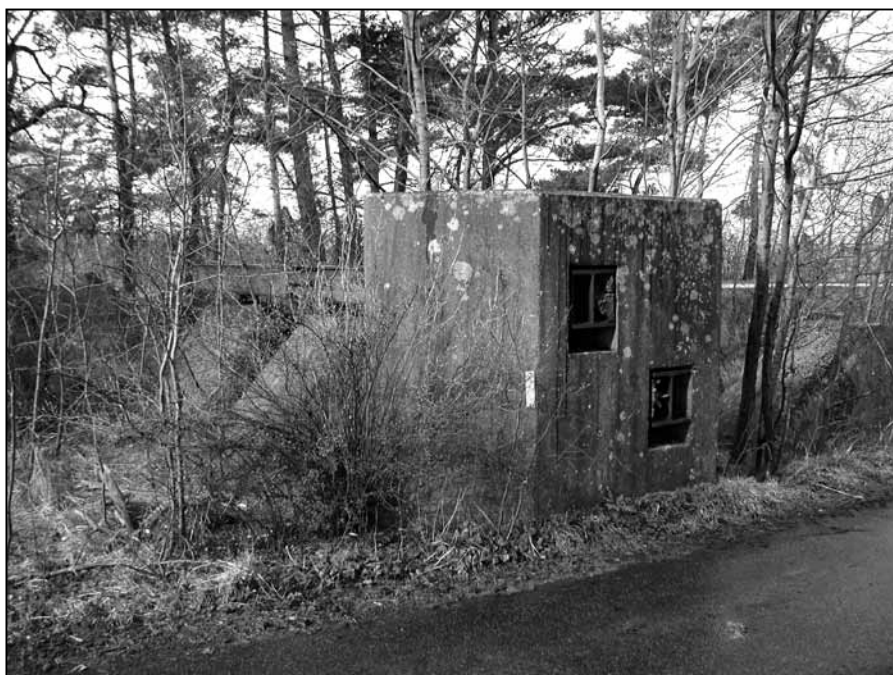
En balkspärr vars stålbalkar kunde spärra järnvägen och landsvägen.
