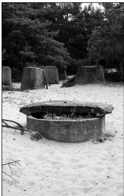
Ovan: ett enkelt skyttevärn med splitterskydd nere på stranden.
