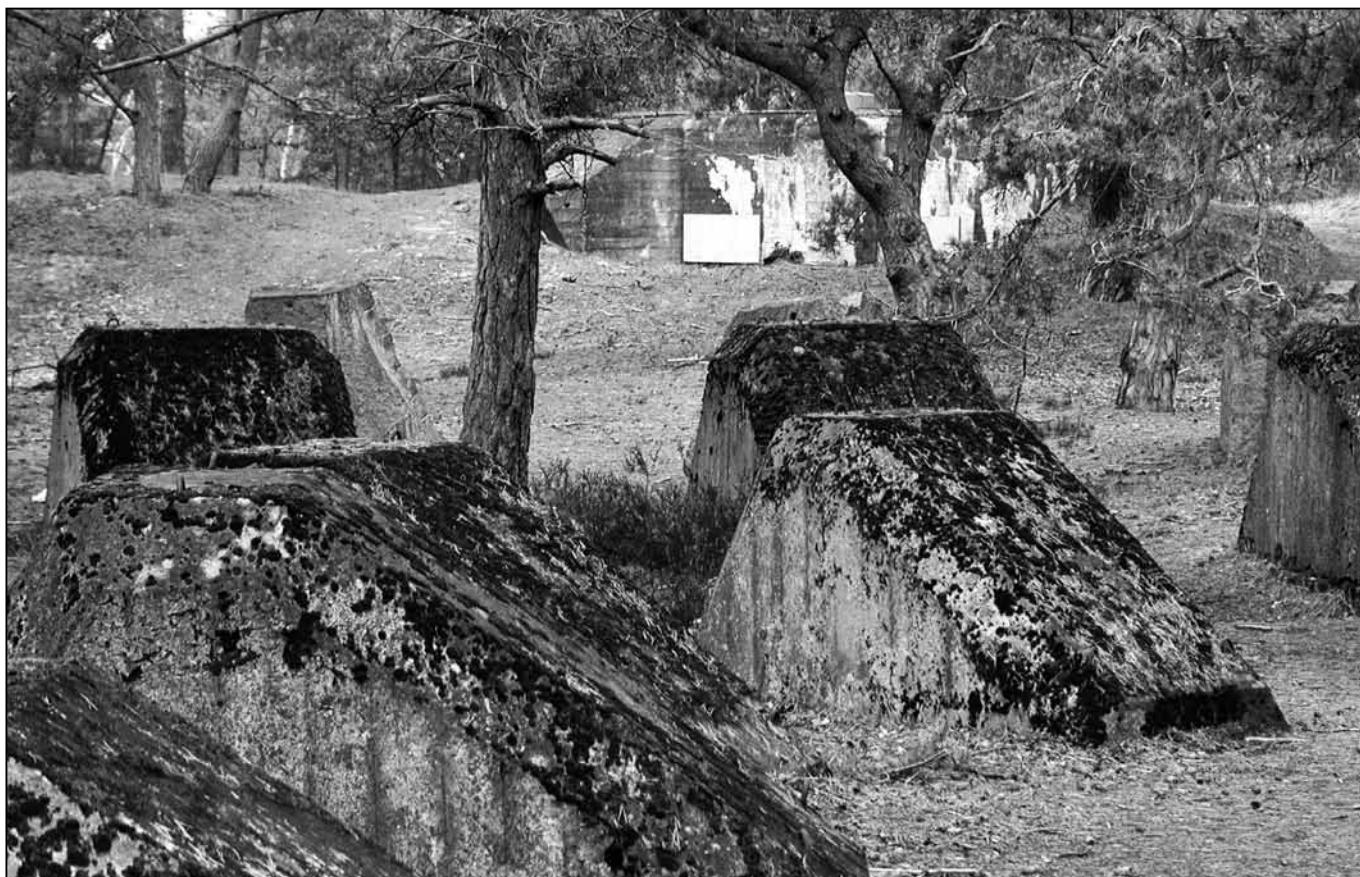
Nedan: spärrlinje med »draktänder« som skulle hindra motoriserad framryckning längs kanalen.
