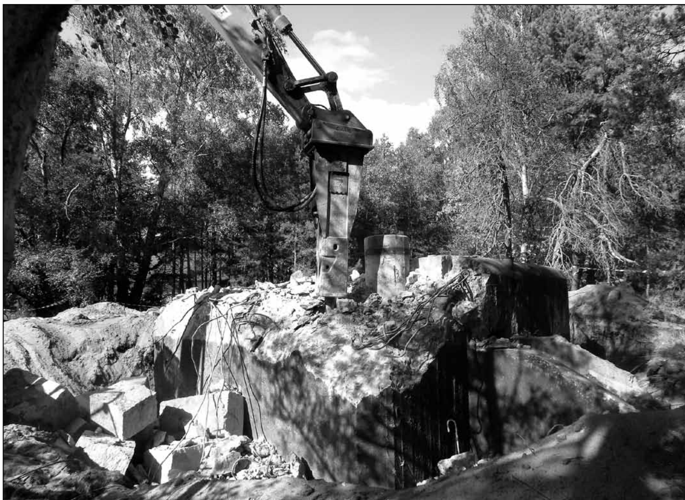
Nedan: Rivningen av en del värn gjordes under hösten 2012. Här är en borrarhammare i full gång.
