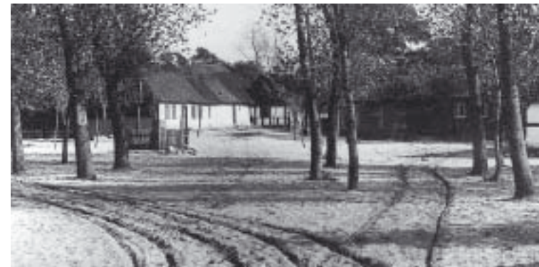
Gamla Torg i Falsterbo med djupa hjulspår i sanden
